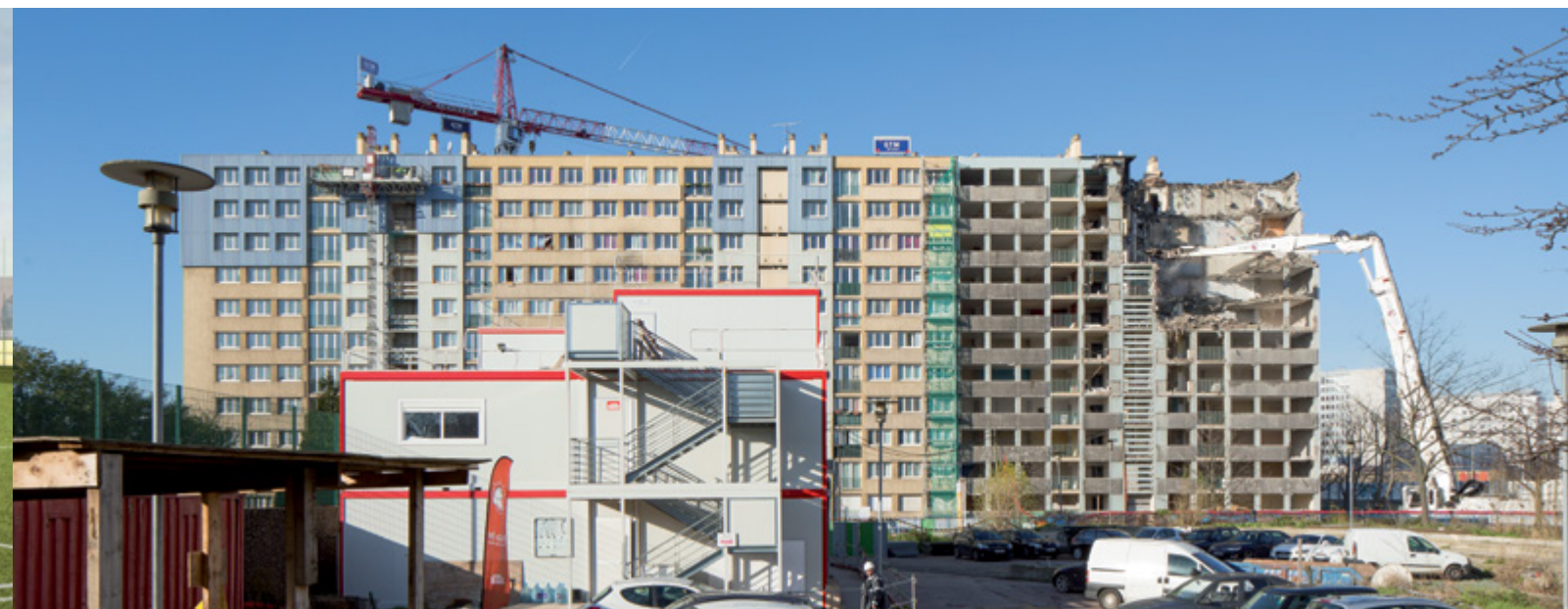
Démolition de la 3 ème cage d'escalier de la barre Borel © Sergio Grazia
