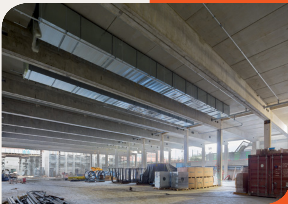
Chantier de l'équipement TAM-Pompiers-Stade vue intérieure © Sergio Grazia
