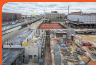
Chantier de l'équipement TAM-Pompiers-Stade vue extérieure © Sergio Grazia
