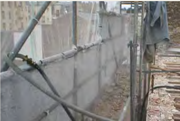
Le BET conseil et maître d'œuvre de la SEMAVIP a mis au point un procédé baptisé « Mur d'Eau ® » dont le dispositif de brumisateurs doublés d'un géotextile confine les poussières de manière très efficace durant les chantiers.
