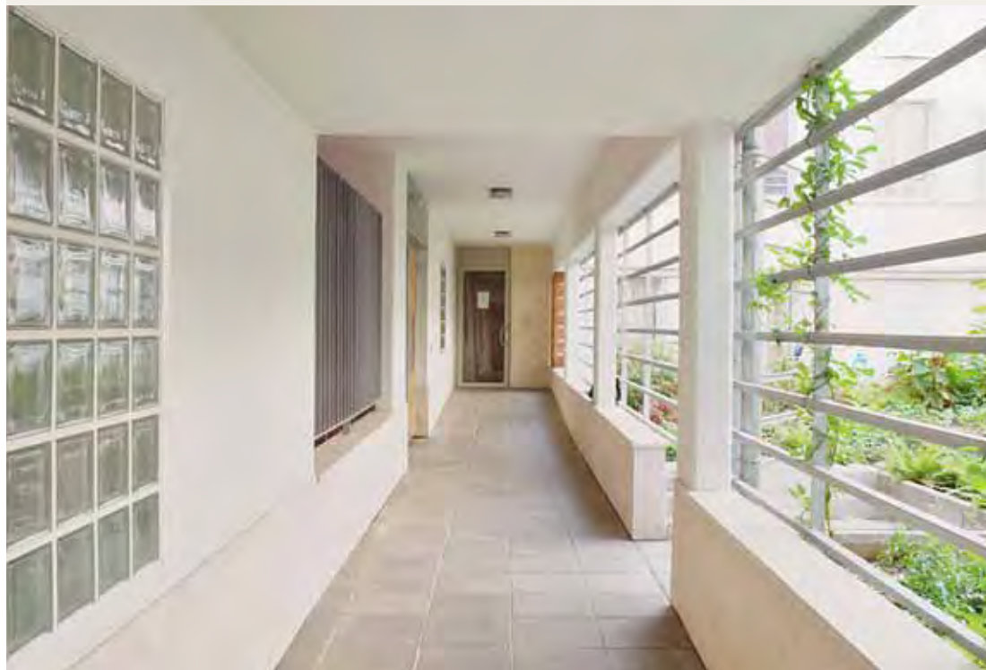
Des programmes de qualité disposant de coeurs d'îlots plantés, remplacent progressivement les bâtiments dégradés. 56 rue Myrha
